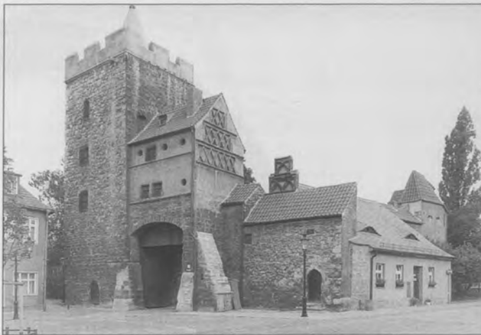
Abb. 1: Das Marientor, Zustand vor der Sanierung 1995. Der vermeintlich gute äußere Zustand läßt die substanziellen Schädigungen des Gebäudes kaum erahnen.
