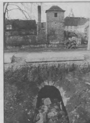
Abb. 5: Die historische Wasserzu- leitung zur Wasserkunst, wie sie bei Bauarbeiten am Wenzelsring 1983 vorübergehend sichtbar war.
