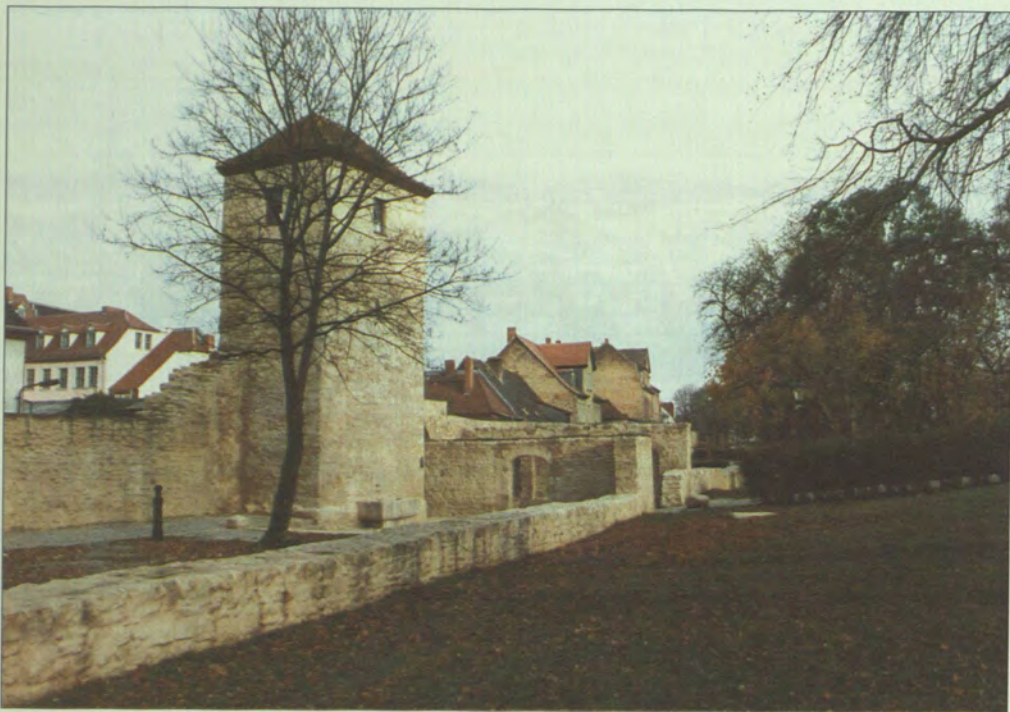
Abb. 4: Die „Wasserkunst“ von der Feldseite, der einzige erhaltene Mauerturm der Mauer des 14. Jhs., heutiger Zustand.
