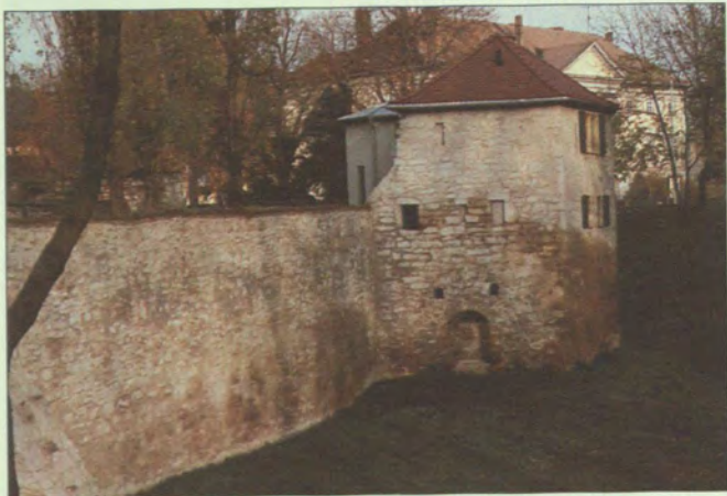
Abb. 11: Die „Landskrone“, die besterhaltene Streichwehr des Zwingers aus dem 15. Jh., an der Südostecke der Stadt. Erbaut 1462/63, aufgestockt wohl 1499/1500 oder 1542; heutiger Zustand.
