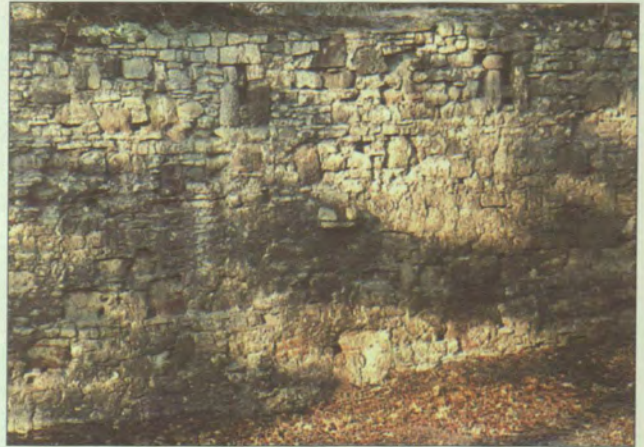
Abb. 12: Der Zwinger nördlich des Jacobstores, originale Brustwehr mit Schlitzscharten; heutiger Zustand.
