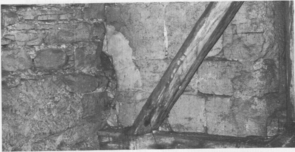
Abb. 3: Romanisches Fenster der ersten Bauphase in der Südmauer des Langhauses.
