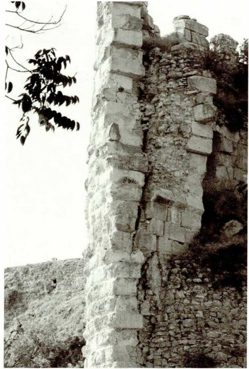
Abb. 10. Der östliche Hufeisenturm an der Angriffsseite, Abbruchstelle der südwestlichen Mauer mit beginnender Ablösung der Mauerschale
