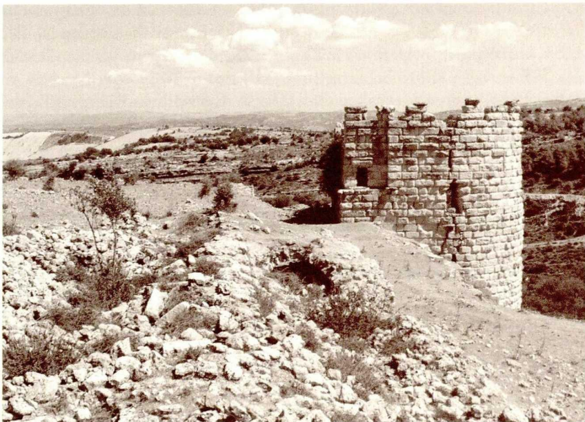
Abb. 13. Der östliche Hufeisenturm von Westen. Der mit Konsolen ergänzte, zurückspringende Gang links ist gut erkennbar, über ihm der Eingang vom ehemaligen Wehrgang. Vorne Reste der inneren Ringmauer und der innen angelehnten Gewölbe
