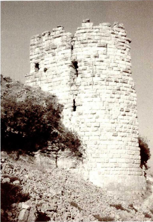
Abb. 12. Der östliche Hufeisenturm vom Halsgraben, von Südwesten
