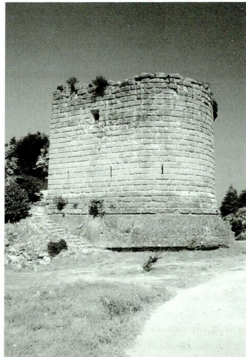
Abb. 18. Der westliche Hufeisenturm von Westen; die Treppe führt zur Poterne und zum Gang mit den Schlitzscharten
