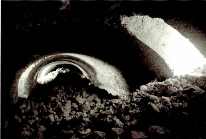
Abb. 8. Blick in die »unterirdische« Halle im Nordosten der Burg
