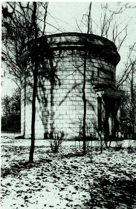
19. Warszawa, Wodociąg w Łazienkach Królewskich. Fotografia z lat 1915–1918 (IS PAN)
