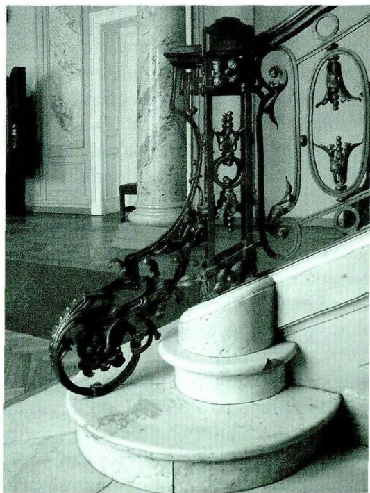
15. Pałac w Połędze, kuta balustrada schodów. Fot. 2006 r.
