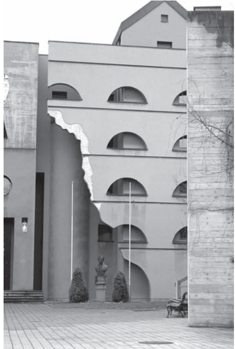
Il. 7. Kraków, postmodernistyczna fasada klasztoru OO. Zmartwychwstańców
