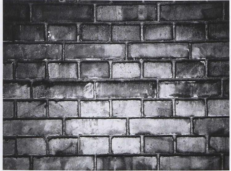
4. „Reichsziegel“ im „Block- oder Kreuzverband“, dabei wechseln sich reine Läufer und Binderschichten ab (1 m Wandlänge)
