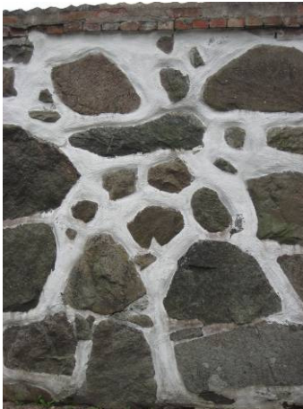
Abb. 7) Gumlösa / Schonen, Feldsteinmauer
