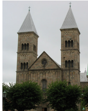
Abb. 8) Viborg / Dom, Westfassade aus Granitquadern
