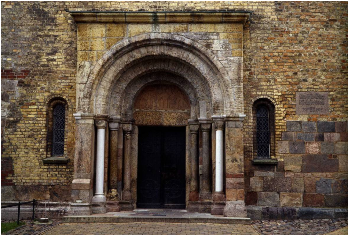
Abb. 18) Schleswig / Dom, Nordportal aus Tuffstein (oberhalb des Portals fand im 12. Jh. der Materialwechsel von Tuff zu Backstein statt)
