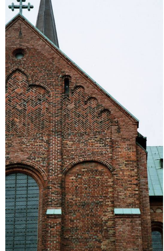
Abb. 167c) Fischgrätmuster, südl. Querhaus
