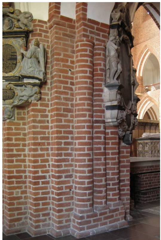
Abb. 151) Roskilde, Gekuppelte Säulen, nordöstl. Chorpfeiler
