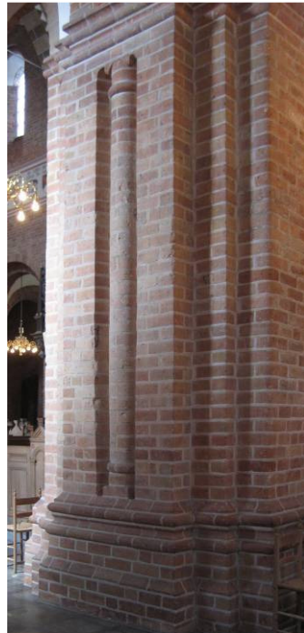
Abb. 46) Versenkte Dreiviertelsäule
