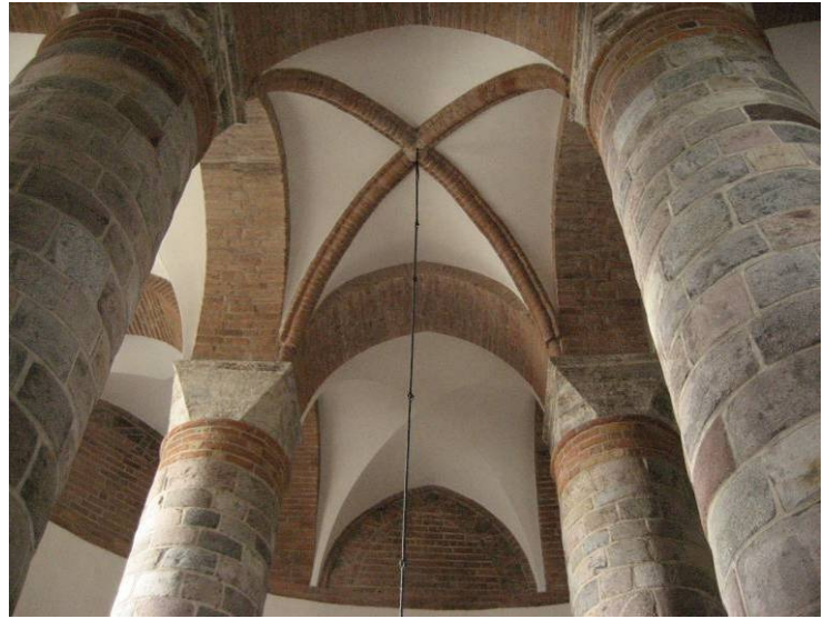
Abb. 90) Materialwechsel innen
