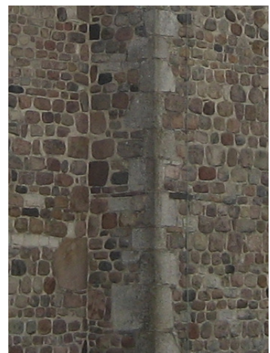
Abb. 76) Detail: Granitmauerwerk
