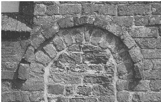
Abb. 179a) Schalsum, Begleitschicht aus auskragenden Bindern, M. 13. Jh.
