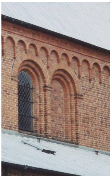
Abb. 54) Sorø, östl. Obergaden (Südseite)
