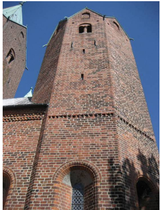
Abb. 103) Kalundborg, Sägeschicht am Ostturm
