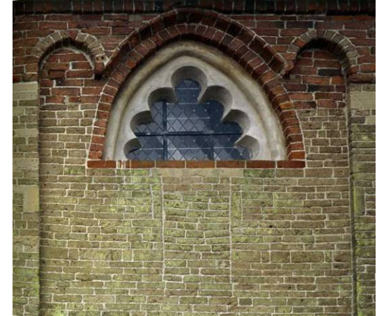
Abb. 6) Hviding / Jütland, kleinformatiger Tuff (Backsteingängzung aus dem 13. Jh.)
