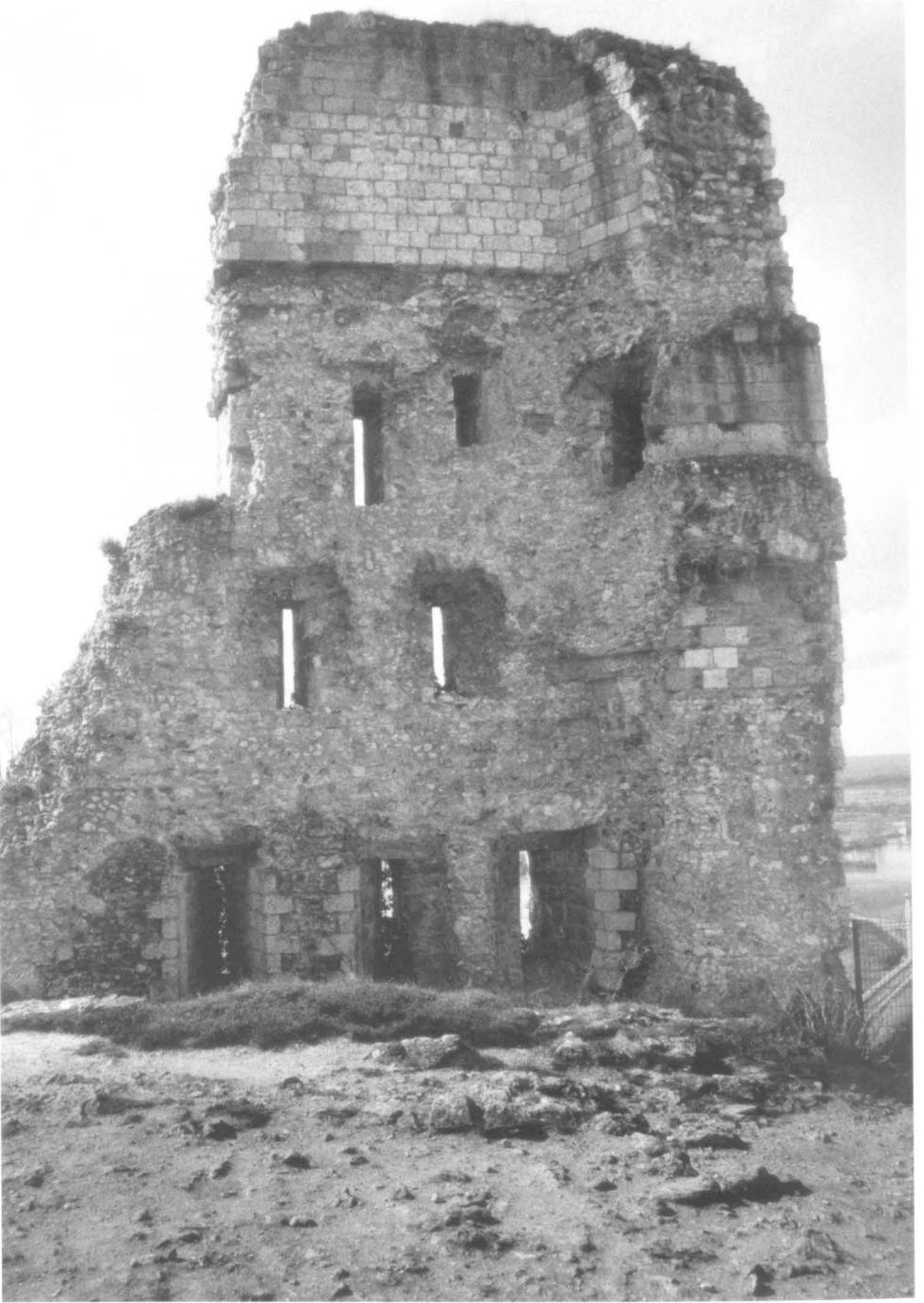
Figure 13: latrines, flanc ouest du château, construit après 1205.
