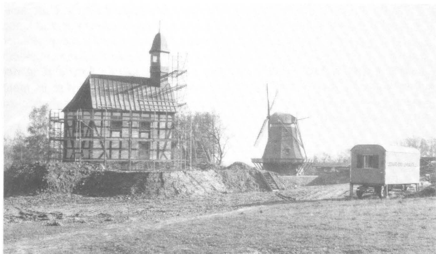
Ehemalige Dorfkirche, künftige Wehrkirche aus Ederbringhausen, im Hintergrund eine für Hessen typische Tal-Windmühle (Originalton Hessenpark: es werden »Bauten aus hessischen Dörfern wiederaufgebaut und zu neuen, idealtypischen Enselmbls gruppiert«. Aufschüttung des Geländes mit Bauschutt.
