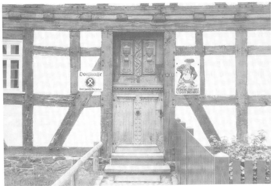
Schulhaus mit Betsaal aus Münchhausen, Eingang mit Runenschild
