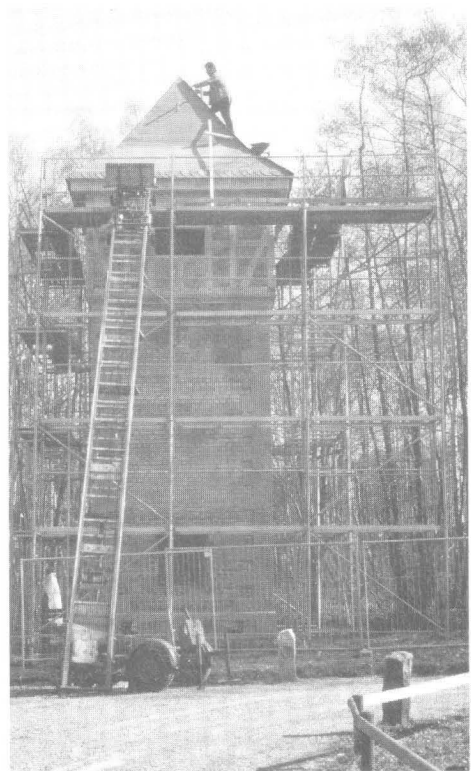
Der Trafoturm des Hessenparkes im Bau
