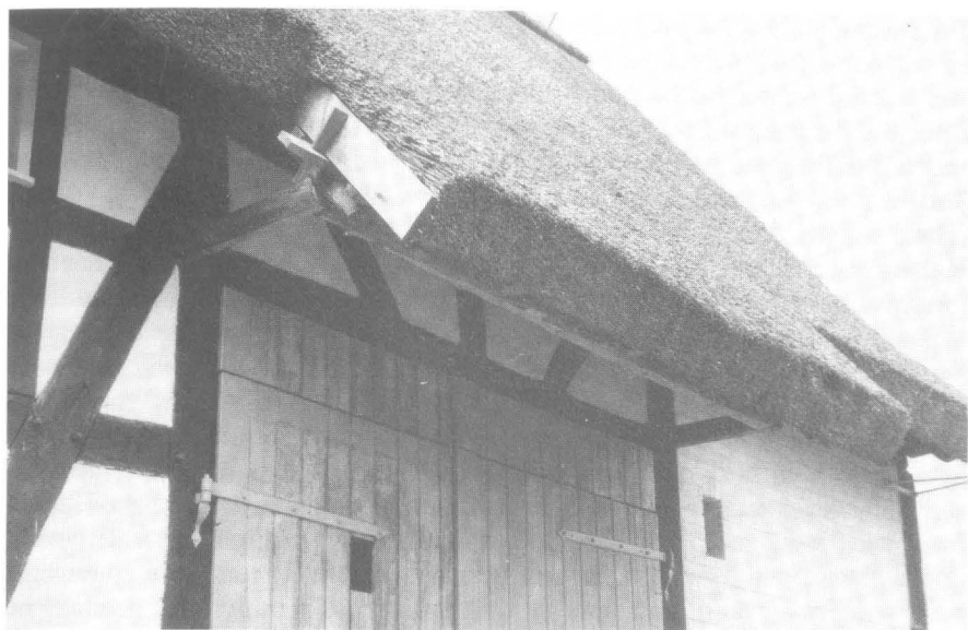
Westerwälder Haus aus Mademühlen, um 1710, mit Umbauspuren des späten 19. Jahrhunderts (Backstein, im Hessenpark weiß gestrichen), Dachdeckung im vermuteten Urzustand (Stroh), romantischer Abschleppung des Strohdaches im Wunschzustand 1991 und Korrektur des Scheunentores auf diesen Zustand hin.
