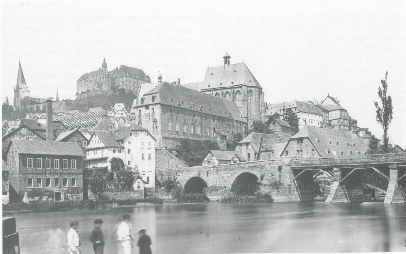
12. Universität von Südosten mit offenem Dachstuhl des neuen Südflügels und altem Aulatrakt, um 1876
