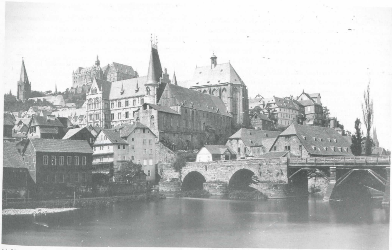
14. Universität von Südosten mit neuem Südflügel und altem Aulatrakt, teilweise mit Nordach, vor 1887
