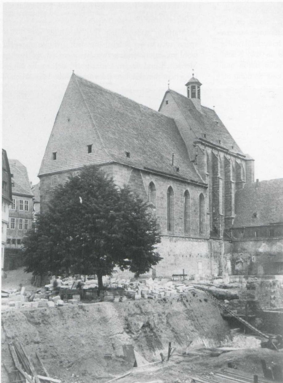
10. Bauplatz des Südflügels (Auditoriengebäude) der neuen Universität, Ende 1873
