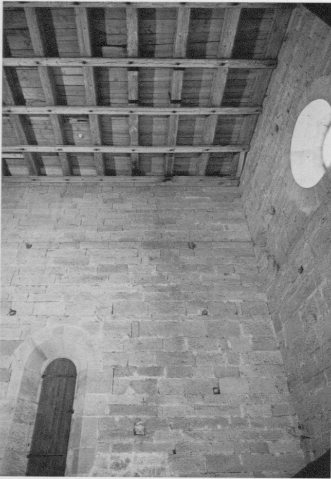
17 Maulbronn, Obergeschossraum im Südquerarm, Blick nach Osten. Originale Dachbalken mit untergenagelten, genuteten Bohlen für die Flachdecke. In der Südostecke ist ein Einschubbrett erhalten.
