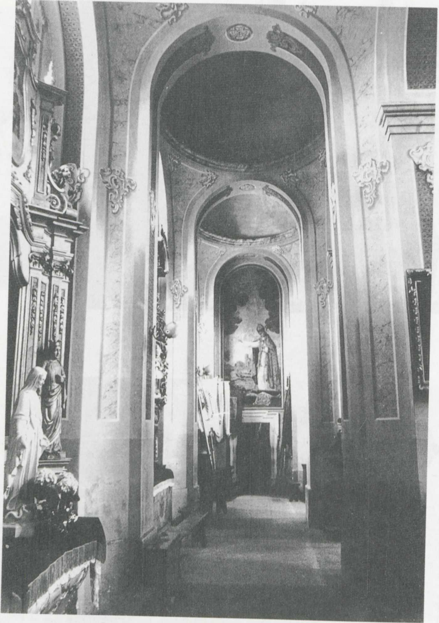
13. Tarnogród. Pfarrkirche – das Innere des südlichen Seitenschiffes. Arch. Bernard Meretyń, 1751–1771. Photo von P. Krasny
