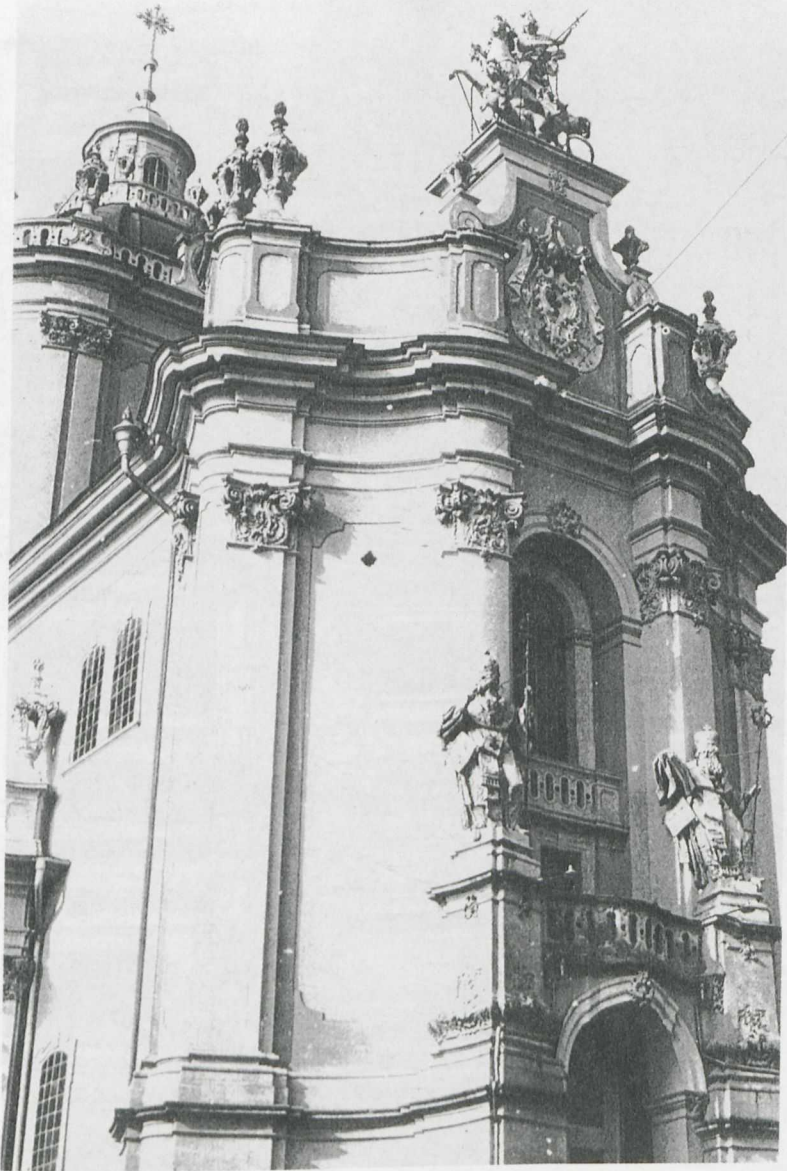
21. Lemberg. St. Jur Kathedrale – Fassade. Arch. Bernard Meretyń, 1743–1771. Photo von J. Sito
