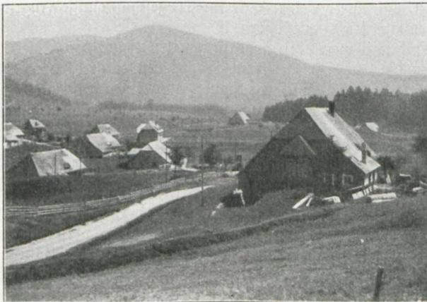
Blick auf Bernau-Weierle. Die meisten auf dem Bilde zu sehenden Häuser haben noch die ursprüngliche,
