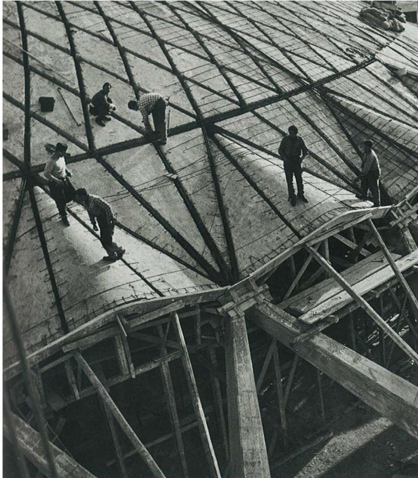
Abb. 27 Pier Luigi Nervi, Bauarbeiten am Palazzetto dello Sport, 1960
