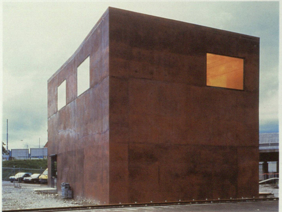
9 Harald F. Müller, Farbgestaltung des Stellwerks der Schweizer Bundesbahn Zürich (in Zusammenarbeit mit Gigon und Guyer, Zürich) Foto: H. Helfenstein
