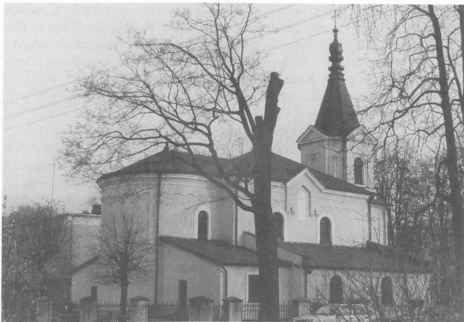
5. Biłgoraj, cerkiew greckokatolicka, 1793–1795. Nawy boczne dobudowane w latach osiemdziesiątych XX w.
