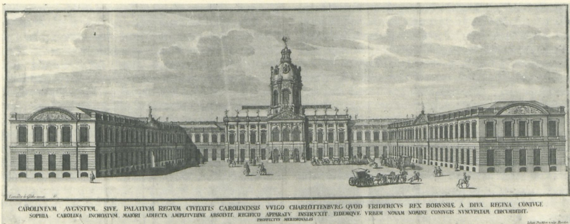
Schloß Charlottenburg. Ansicht von der Hofseite. Kupferstich, um 1712
