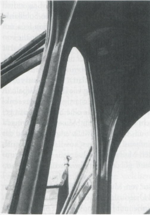
Abb. 5. Troyes, Saint Urbain, Pfeiler der nördlichen Querhausvorhalle
