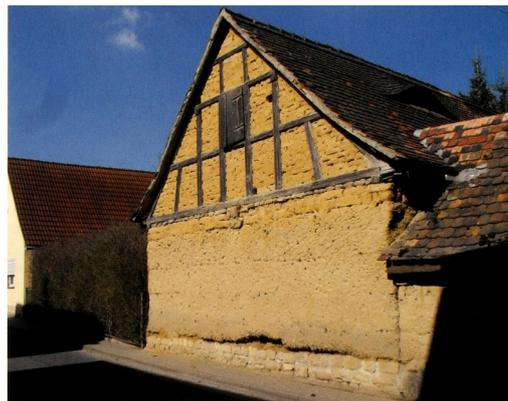
An diesem Haus aus Saaleck erkennt man deutlich die einzelnen schräg geschichteten Lehmlagen. Der Giebel ist in Fachwerk aufgeführt, hier aber mit Lehmsteinen zugesetzt (Foto: Hagen Garwurnke).
