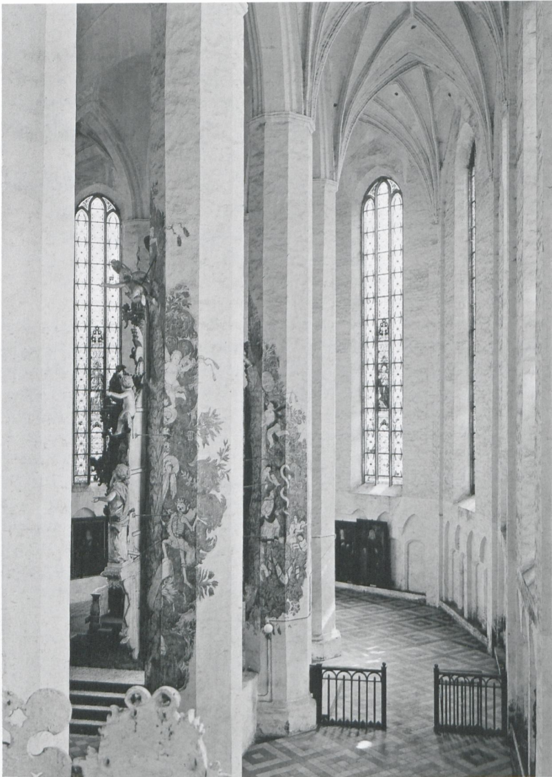
70 Luckau, Pfarrkirche St. Nikolai, südliches Seitenschiff
