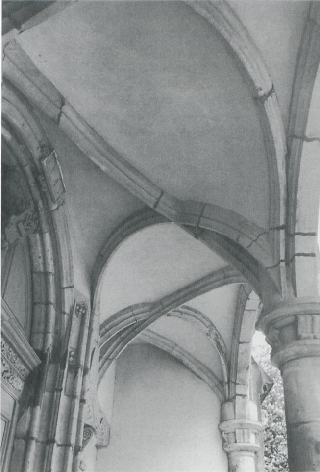
Abb. 2: Görlitz, Peterskirche, Nordportalvorhalle; evtl. Werk des Meisters Wendel Roskopf. Das gotische Portalgewände wurde im Bogen verändert. Der Wandaufsatz erhielt französische Renaissanceformen, die auf das Schloss Chambord (ab 1519) zurückzuführen sind. Die Vorhalle erhielt ein gotisches Schlingrippengewölbe analog zu Wölbungen der Prager Burg (um 1500).
