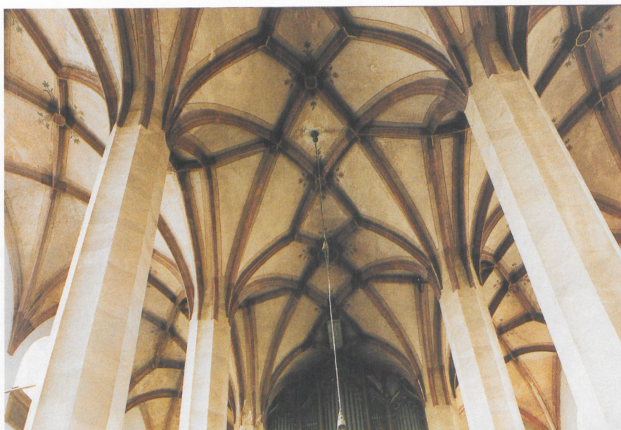
Abb. 10 Sayda, Marienkirche, Gewölbe im Langhaus (um 1502), Blick nach Westen, 2002 (Foto: Verfasser)
