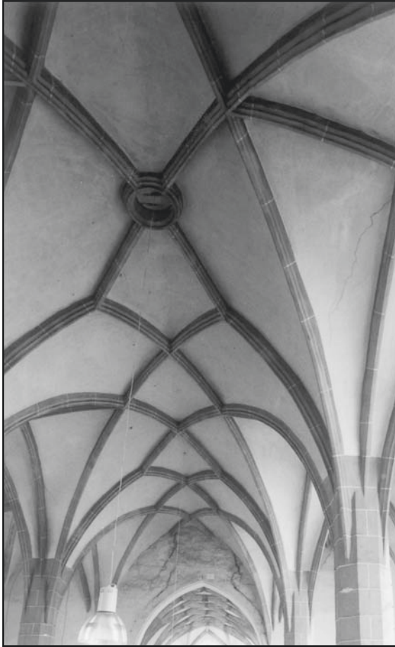
Abb. 1: Klosterkirche St. Anna in Kamenz, Langhausgewölbe. – Foto: Stefan Bürger.
