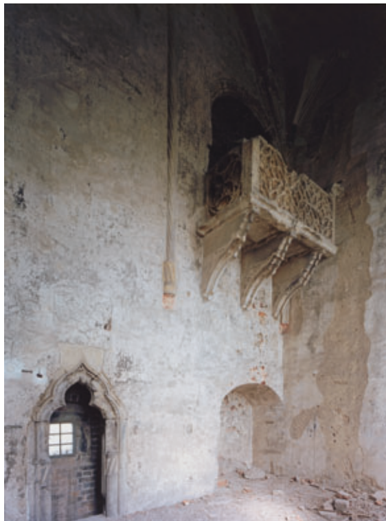
Abb. 16 Bautzen, Ortenburg, Matthiasturm, Empore vor der Sanierung.
