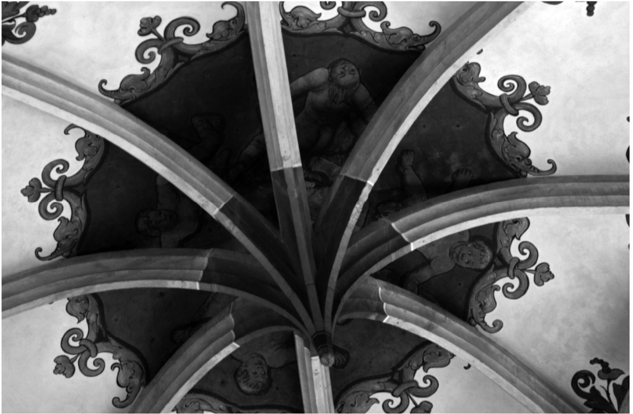
Abbildung 3: Marienkirche Pirna, hängender Schlussstein mit Engelsreigen. Die aufgemalte Öffnung des Himmels beginnt genau dort, wo sich die Rippen vom Wölbgrund lösen. Foto: Stefan Bürger
