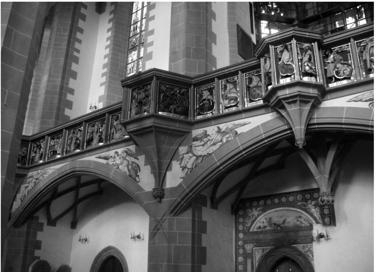
Abbildung 4: Annenkirche Annaberg, hängender Schlussstein im Emporengewölbe. Davor befindet sich als nördliches Pendant zur südlichen Heiltumskanzle (?) ein kanzelartiger Brüstungskorb mit Abhängling. Foto: Stefan Bürger
