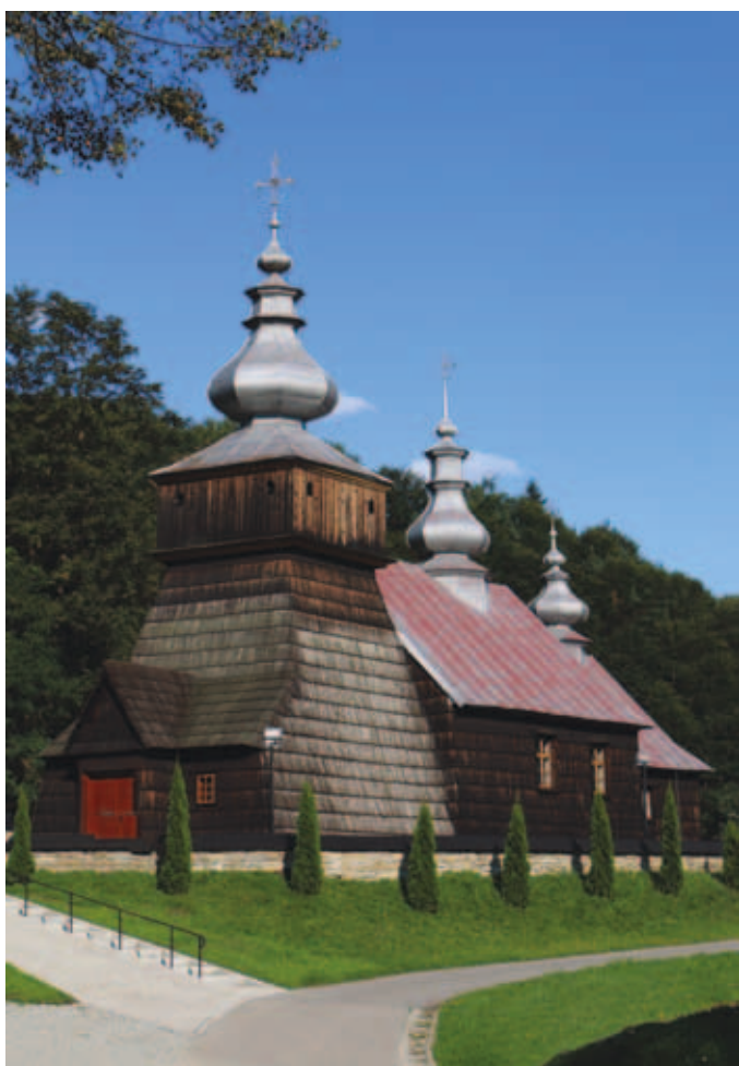
20. Cerkiew pw. św. Michała Archanioła w Polanach – widok obecny
