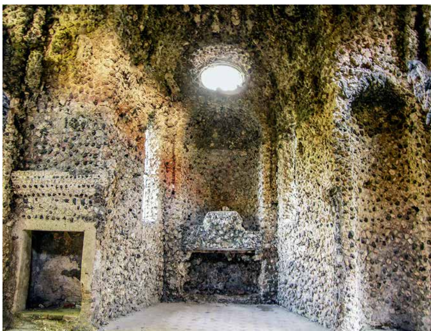
21. Praga, kaplica św. Eliasza, fot. M. Kurzej
