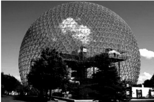
Abbildung 575: Richard Buckminster Fuller – Biosphère / Ile Ste-Hélène Montreal 1967 – Kugel auf Basis des Dreiecks u. Geodätischer Linien
