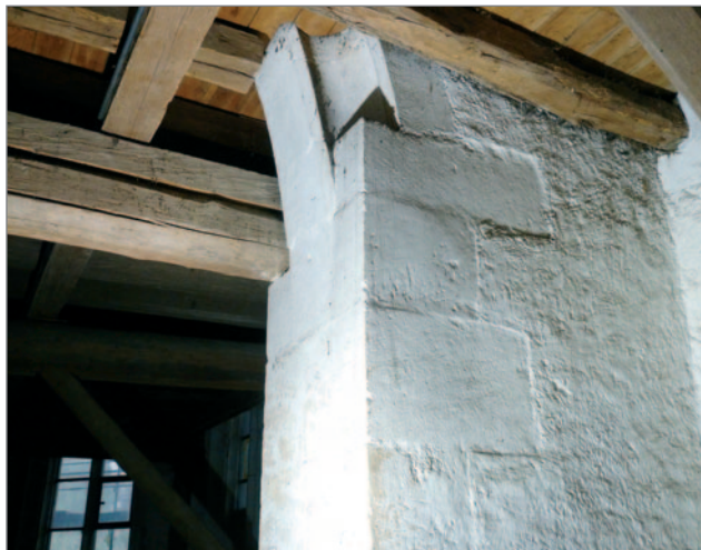
Abb. 27 (links): Blick auf die südliche Außenwand, strebe Pfeilerartiger westlicher Abschluss des Altarraumes, an den später die südliche Kapellenschiffmauer angeschlossen werden sollte, Aufnahme: Charlotte Lagemann.
