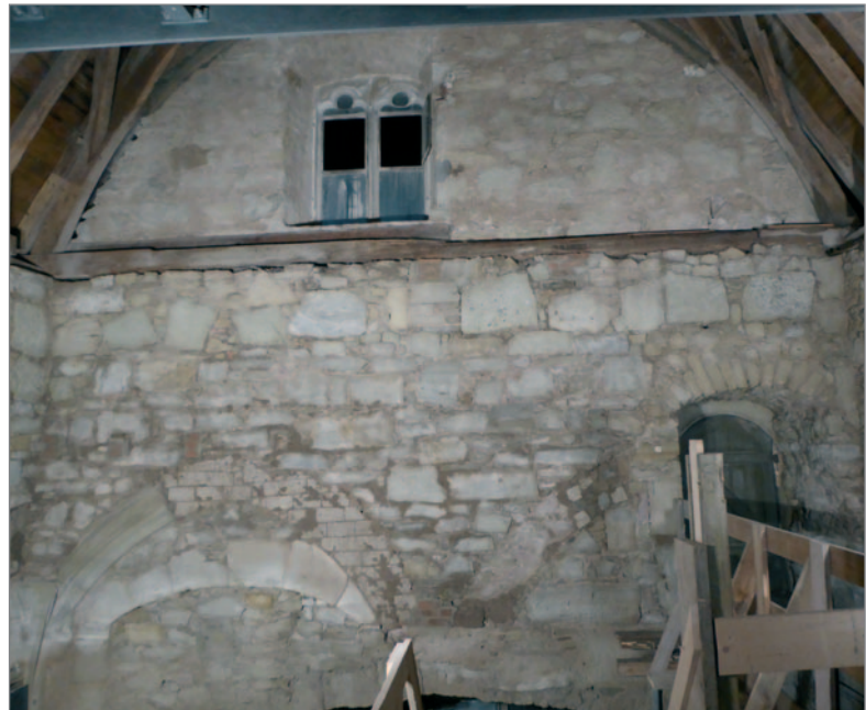
Abb. 13: Innenraum nach Westen nach Beseitigung des Wandputzes, deutlich zu erkennen ist der Mauerrücksprung in Traufhöhe.
