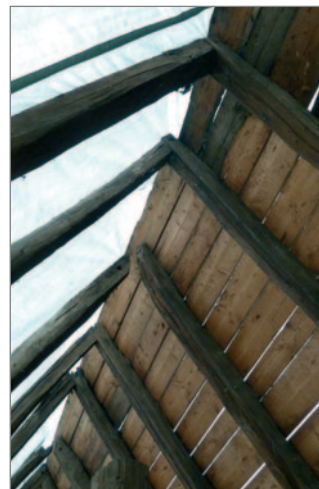
Abb. 33 (o.): Dachwerk über dem Altarraum mit einer Hängewerkkonstruktion für einen Dachreiter, Aufnahme: Britta Hedtke.
