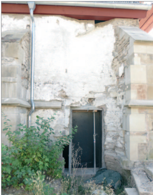
Abb. 12: Treppenturmreste im westlichen Abschnitt der Kapellennordwand mit Resten zweier Trittstufen.
