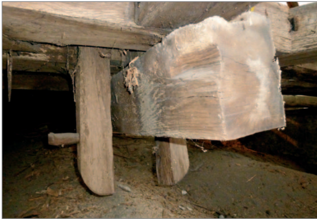
Abb. 35: Dachwerk über dem Altarraum, zerstörtes Zapfenschloss, Aufnahme: Britta Hedtke.
