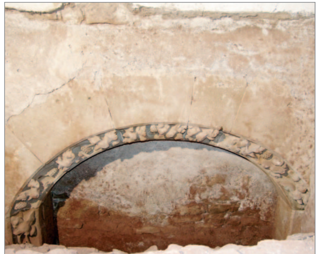
Abb. 62: Weinrankennische an der nördlichen Kapellenschiffwand, Aufnahme: Stefan Schopf/Firma Hangleiter.
