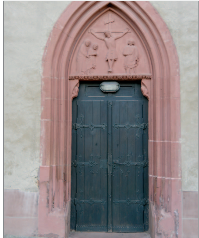
Abb. 51: Nordportal der kath. Pfarrkirche St. Peter und Paul in Eltville am Rhein, Aufnahme: Christian Hedtke.
