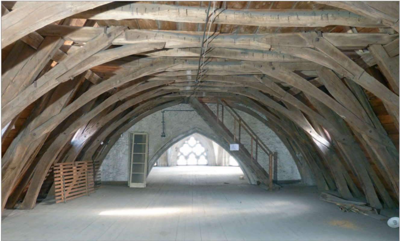
Abb. 38: Liegender Dachstuhl über dem Kapellenschiff.
