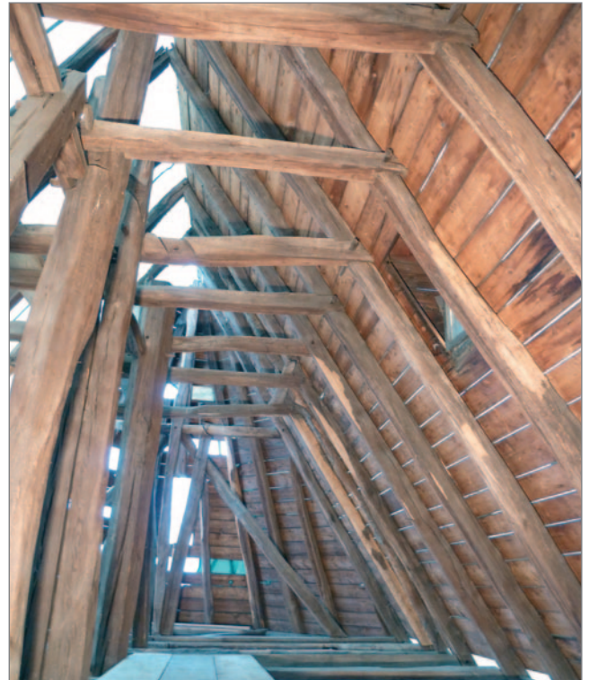
Abb. 33 (o.): Dachwerk über dem Altarraum mit einer Hängewerkkonstruktion für einen Dachreiter, Aufnahme: Britta Hedtke.
