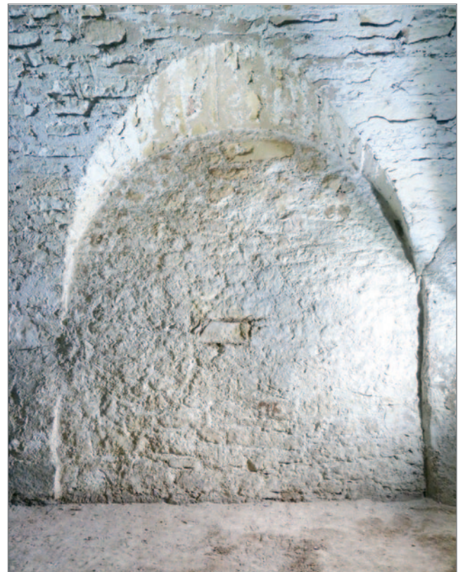
Abb. 43: Keller im Bereich des Altarraumes, in der Nordwand schneidet eine bis zum Boden reichende Stichkappe ins Tonnengewölbe ein; diese öffnete sich ursprünglich in voller Breite zur angrenzenden Sakristei.
