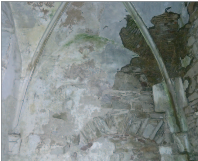
Abb. 8: Südwand der Sakristei, Aufnahme: Christian Hedtke
