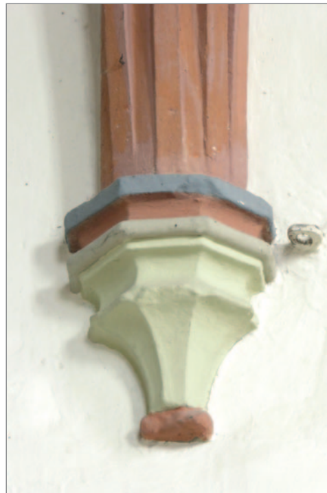
Abb. 67: Gewölbekonsole Altarraum der ehem. Johanniterkapelle in Bad Sobernheim, Aufnahme: Christian Hedtke.
