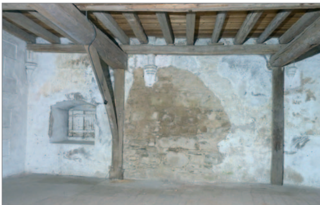
Abb. 26: Blick auf die nördliche Innenwand des Altarraumes nach Teilentfernung des Wandputzes, Aufnahme: Britta Hedtke.
