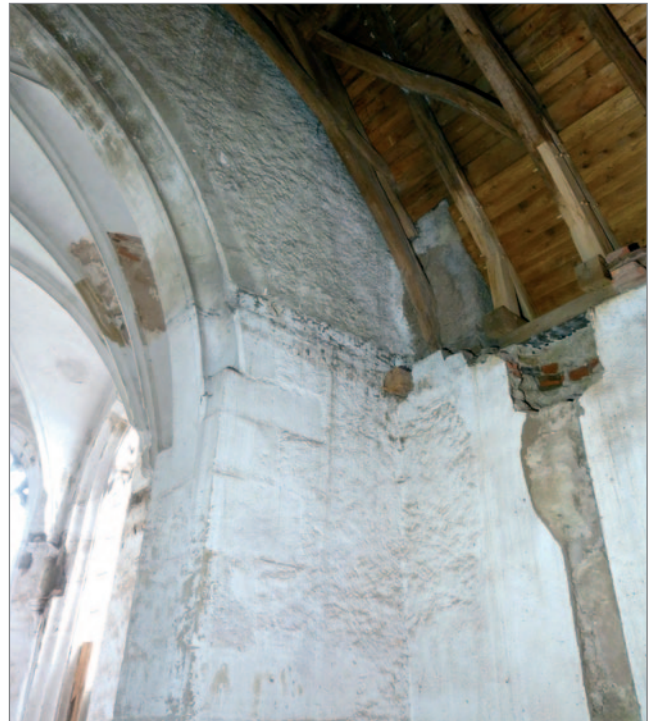
Abb. 36: Westseite des südlichen Triumphbogenpfeilers mit provisorisch aufgetragenem Verputz, Aufnahme Britta Hedtke.
