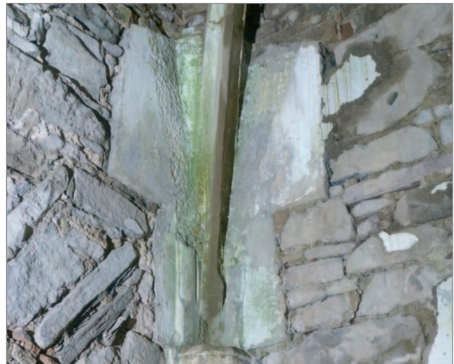
Abb. 9: Gewölbeanfänger in der Südwestecke der Sakristei mit Schildbogenresten, Aufnahme: Christian Hedtke 2013.
