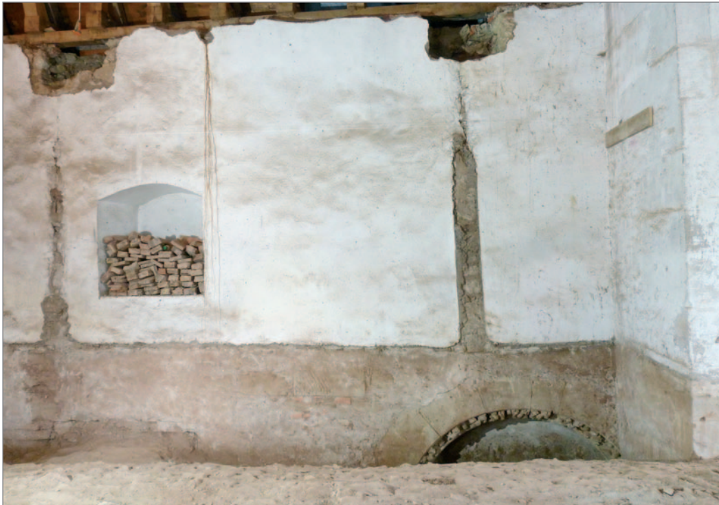
Abb. 23: Blick auf die nördliche Innenwand des Kapellenschiffs nach dem Ausräumen der Gewölbeverfüllung, östlicher Abschnitt mit freigelegter Weinrankennische, Aufnahme: Britta Hedtke.
