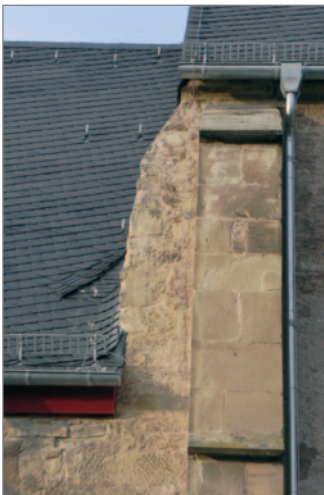
Abb. 27 (links): Blick auf die südliche Außenwand, strebe Pfeilerartiger westlicher Abschluss des Altarraumes, an den später die südliche Kapellenschiffmauer angeschlossen werden sollte, Aufnahme: Charlotte Lagemann.
