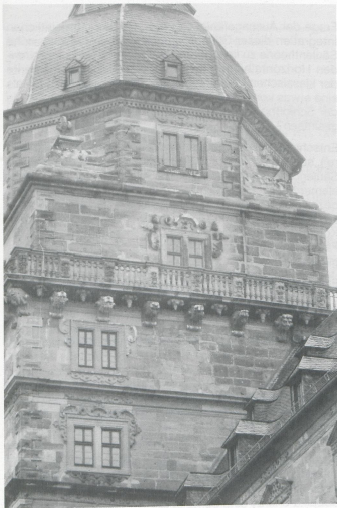
4.2 Ansicht des südlichen Außenturmes von Südosten
