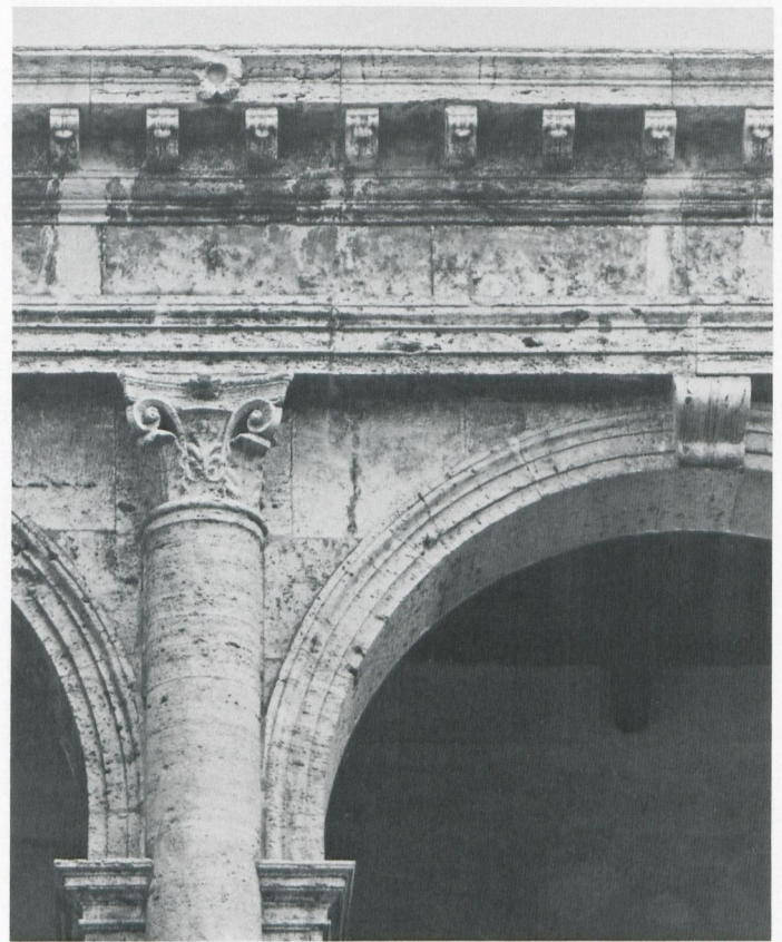
117. Palazzo Venezia, Hof, Detail der oberen Loggia
