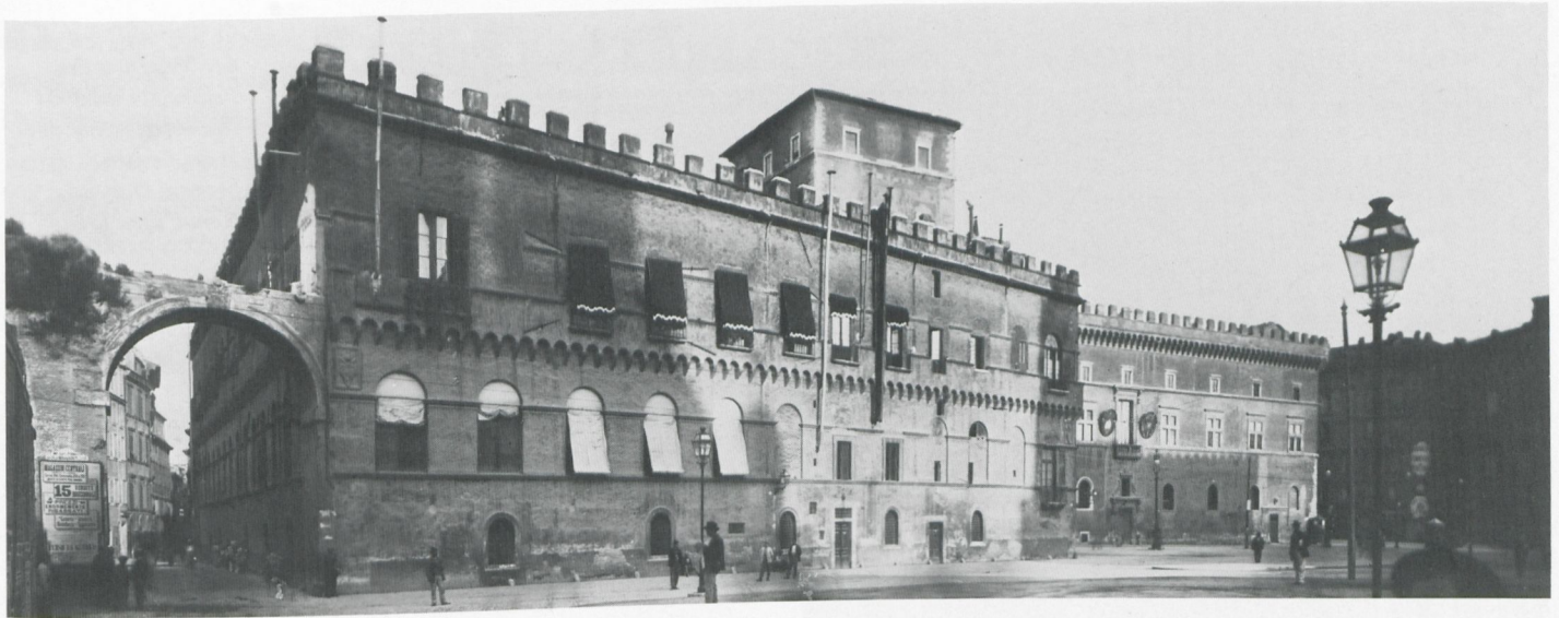
14. Palazzetto, Ansicht von Südosten vor 1911
