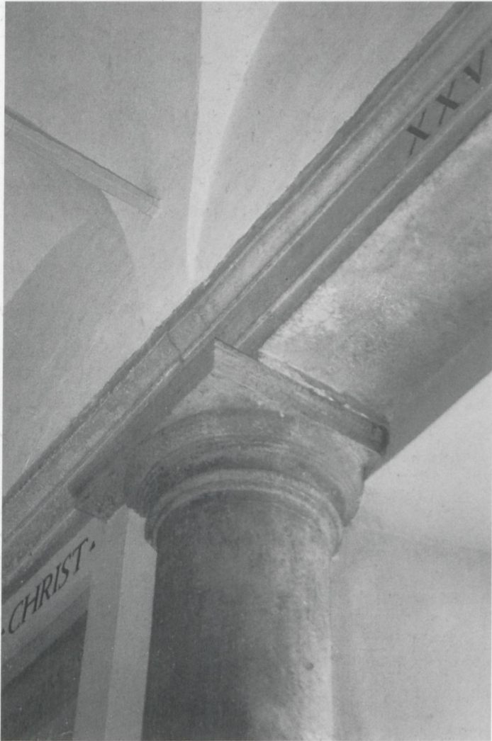
Fig. 60 Capitello del terzo piano del cortile inferiore
