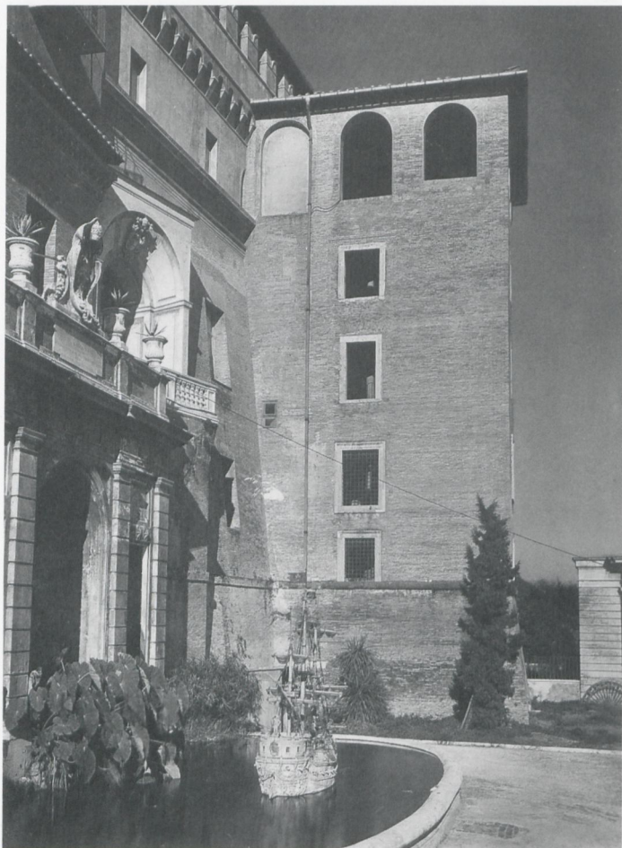
Fig. 51 Zona tra il muro orientale del giardino superiore e la scala a chiocciola
