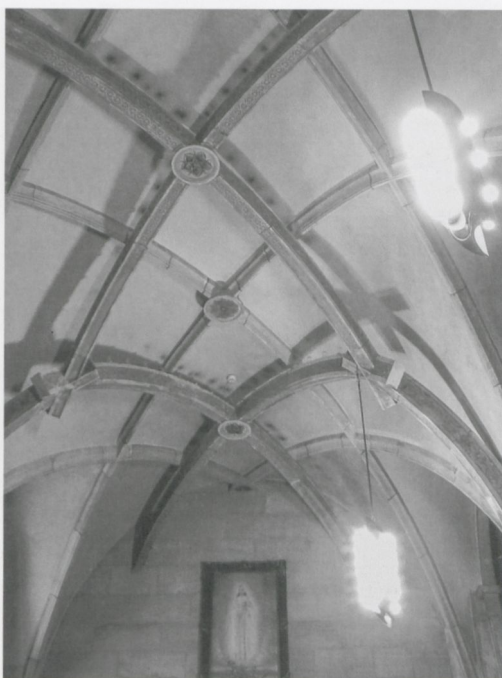
Abb. 12. Prag, Veitsdom, Orgelempore, Gewölbe im Erdgeschoss
