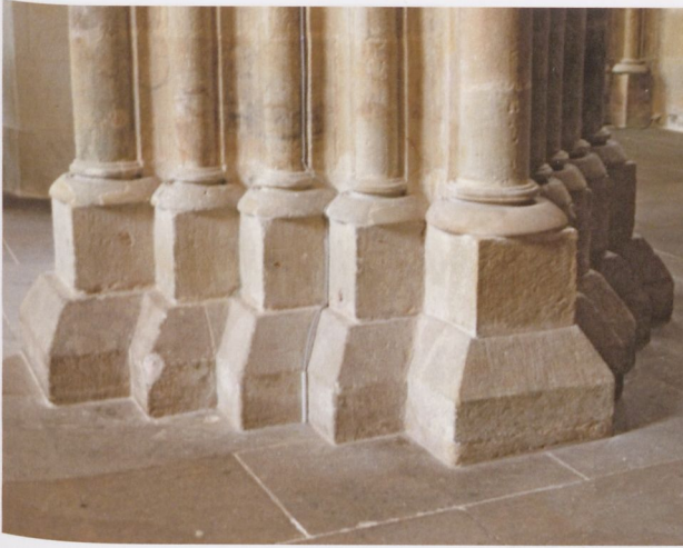
13 Dom Meissen, Langhauspfeiler, die kissenförmigen Basen vermitteln ein Auflasten Meissen Cathedral, nave pillars, the pillow-shaped bases convey a burden
