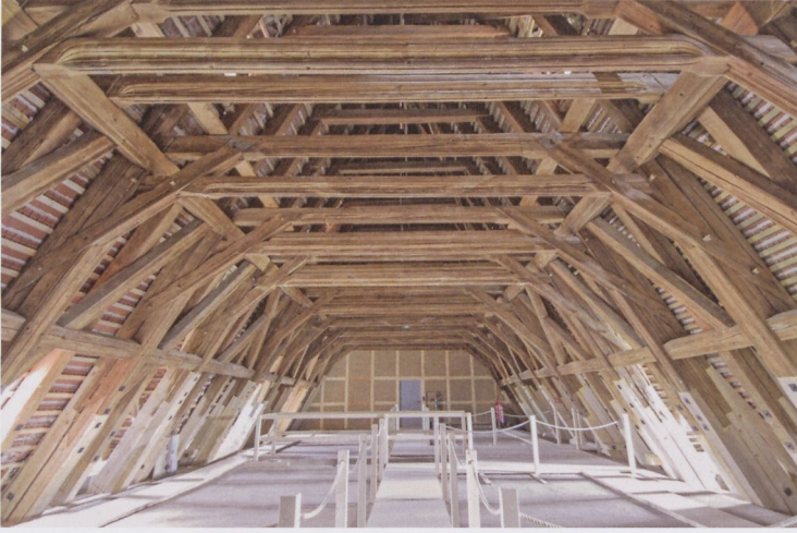
11 Albrechtsburg Meissen, Dachwerk des Mittelbaus Albrechtsburg Meissen, roofing of the middle building
