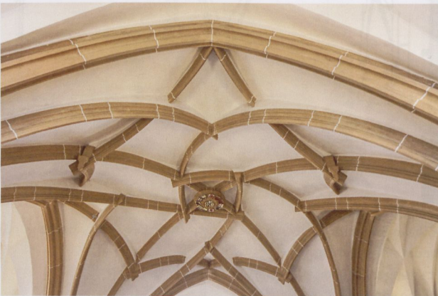
22 Albrechtsburg Meissen, Wappensaal; Schlingrippengewölbe mit vier Kreuzungspunkten im Scheitel Albrechtsburg Meissen, coat-of-arms hall; twined rib vault with four crossing points in the vertex
