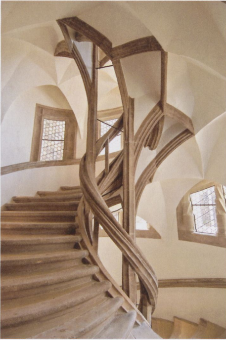
20 Albrechtsburg Meissen, Großer Wendelstein; drei schlanke Pfeiler nehmen den Schub des Gewölbes auf Albrechtsburg Meissen, grand spiral stair tower; three slender pillars absorb the vault's thrust
