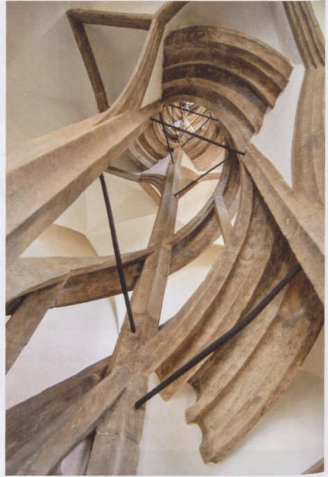
21 Albrechtsburg Meissen, Großer Wendelstein; die Eisenanker/Druckanker leiten die Schubkräfte des Gewölbes ab Albrechtsburg Meissen, grand spiral stair tower; the iron anchors / pressure anchors deflect the vault's thrusting forces
