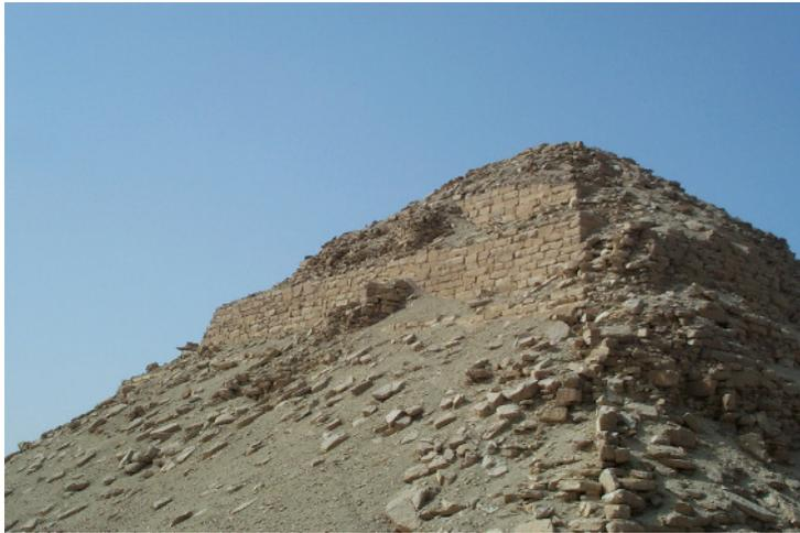
Abb.13 Pyramide des Neferirkare mit den deutlich sichtbaren oberen Stufen des Kernmauerwerks. Foto Müller-Römer.
