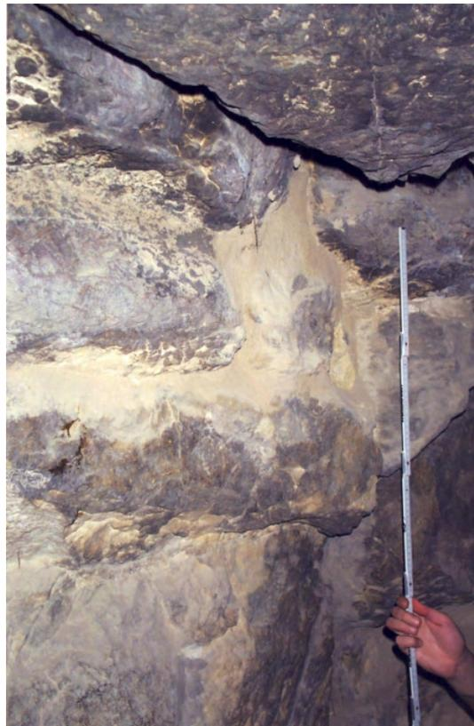
Abb. 5.1.2.2.4 Schicht 7, bestehend aus flachen, übereinander angeordneten Steinen ca. 15 m vom Eingang entfernt
