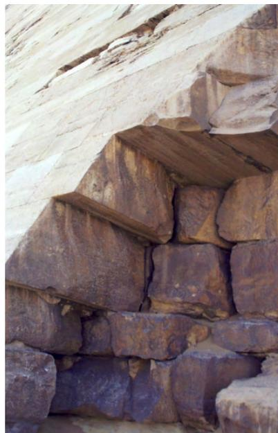
Abb. 4.1.2 Äußere Verkleidungsschicht der Knickpyramide, bestehend aus unterschiedlichen Steinformaten
