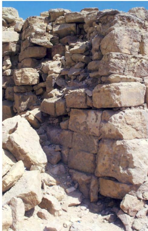
Abb. 5.1.2.3 Kernmauerwerk an der Westseite des Pyramide des Djedefre
