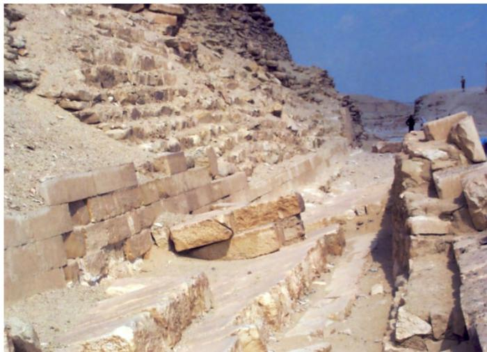
Abb. 5.1.1.1 Fundament der äußeren östlichen Verkleidungsschicht der Pyramide des Djoser
