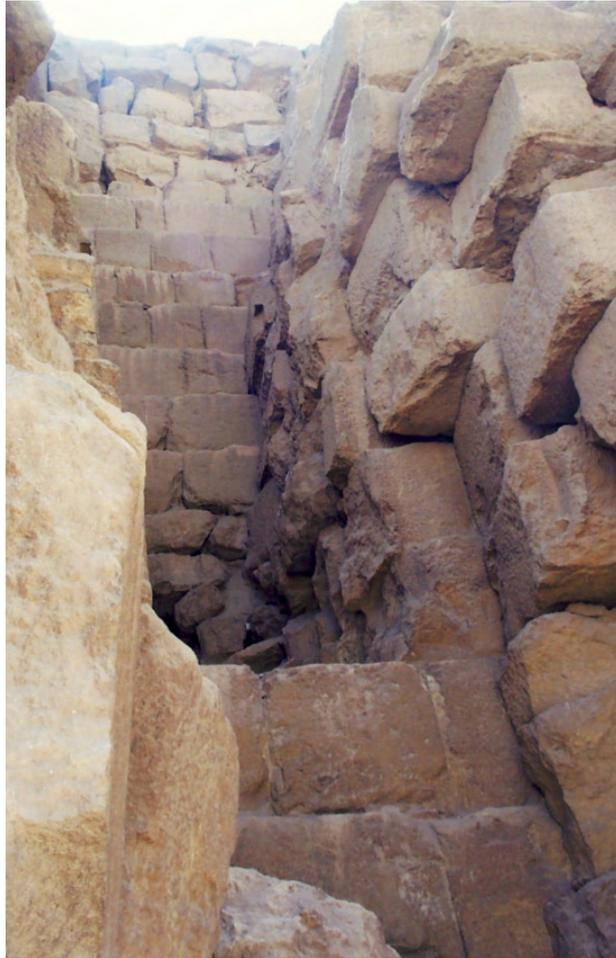
Abb. 5.1.2.6.3 3. Stufe (Vordergrund) und 4. Stufe (Hintergrund) des Kernmauerwerks der Pyramide des Mykerinos
