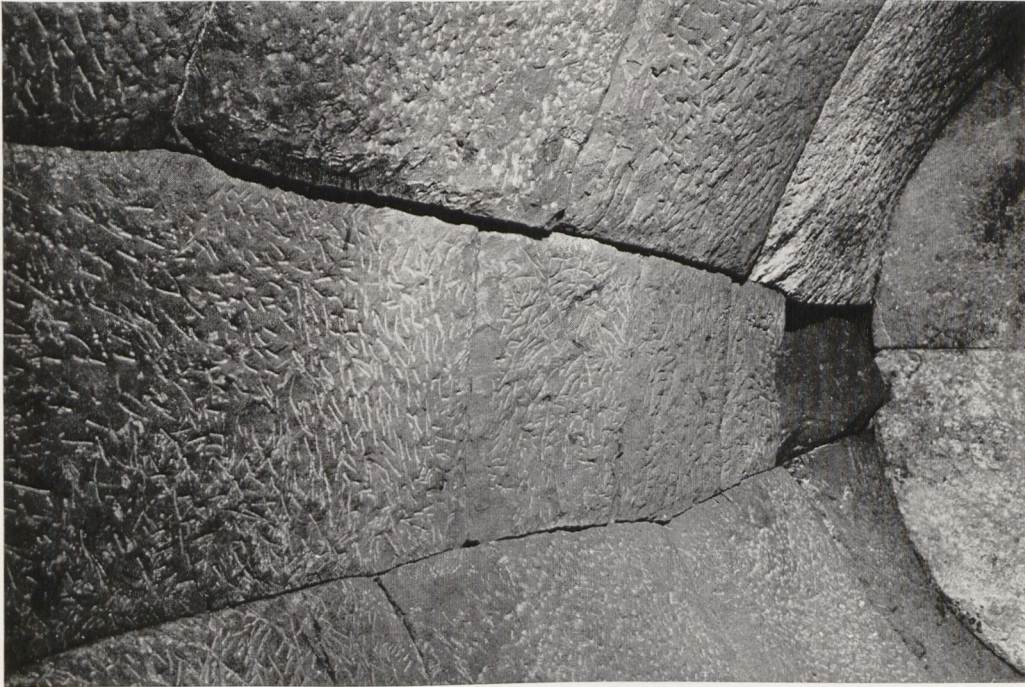
2. Schlußsteine des Tonnengewölbes der Grabkammer von Nordwesten
