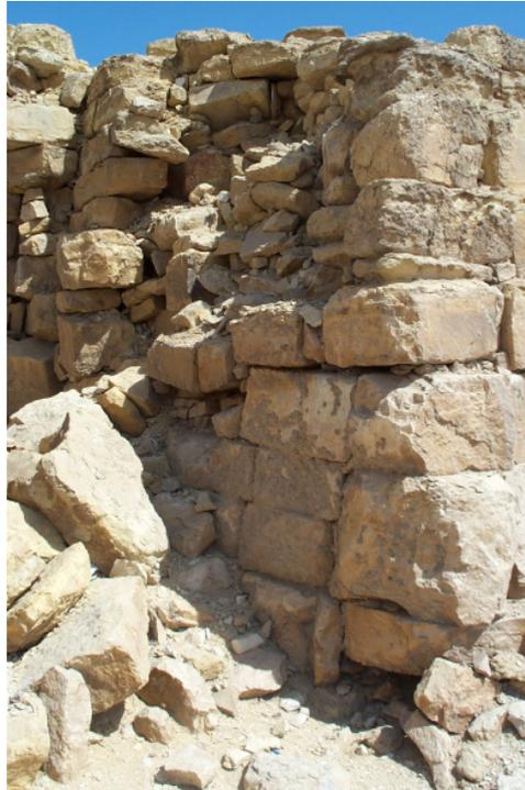
Abb. 5.1.2.3 Kernmauerwerk an der Westseite des Pyramide des Djedefre
