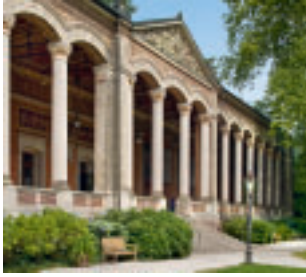
Die Trinkhalle von Heinrich Hübsch in Baden-Baden.
