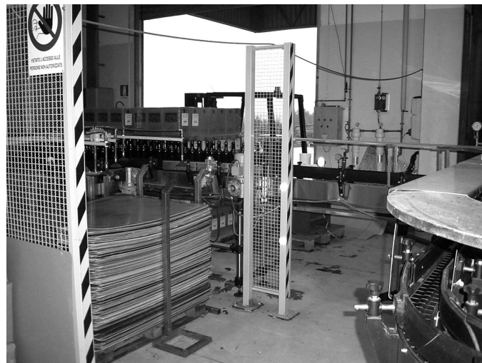
Abb. 14: Automatisierung bei Torrevento: depalletizzatore
