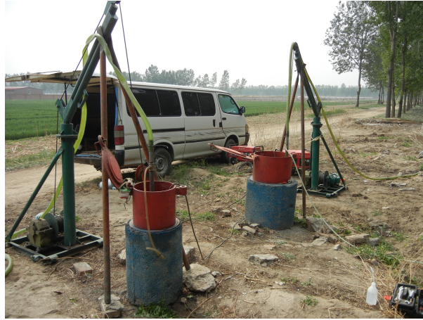
(b) ...mit installierten Pumpen
