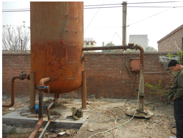
(d) Produktionsbrunnen für Trinkwasserversorgung mit Speichertank
