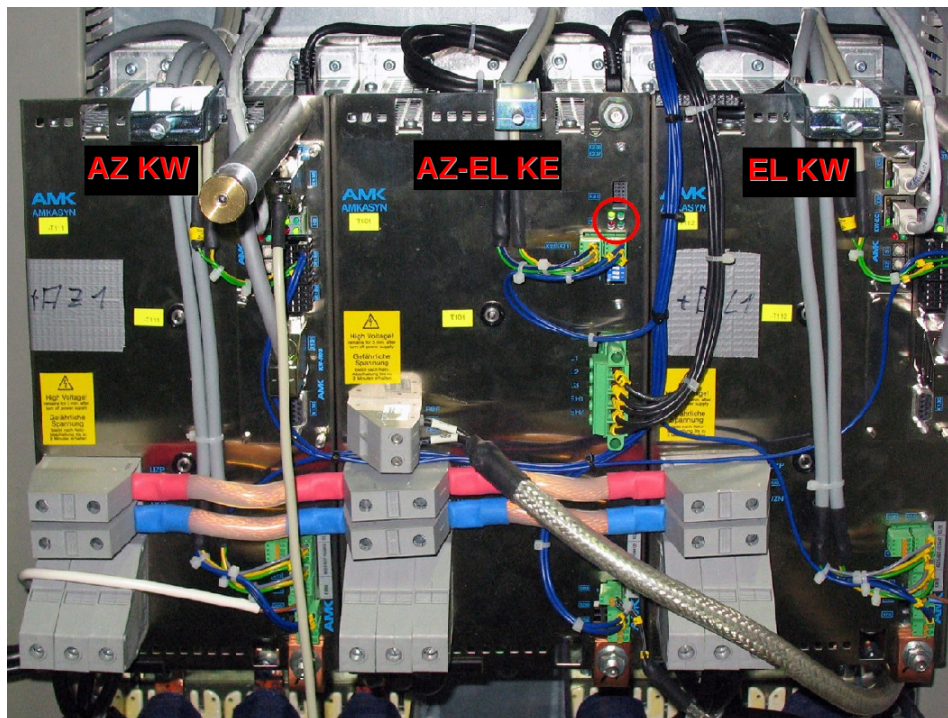
ABBILDUNG 7.7: Die Servo-Umrichter KE und KW
