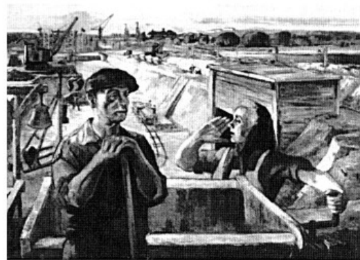
Abb.122 Werner Laux, Werftneubau (Werft Wismar) 1951
