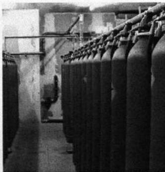
Bild 3: Die CO<sub>2</sub>-Flaschen sind in Batterien zusammengefasst.
