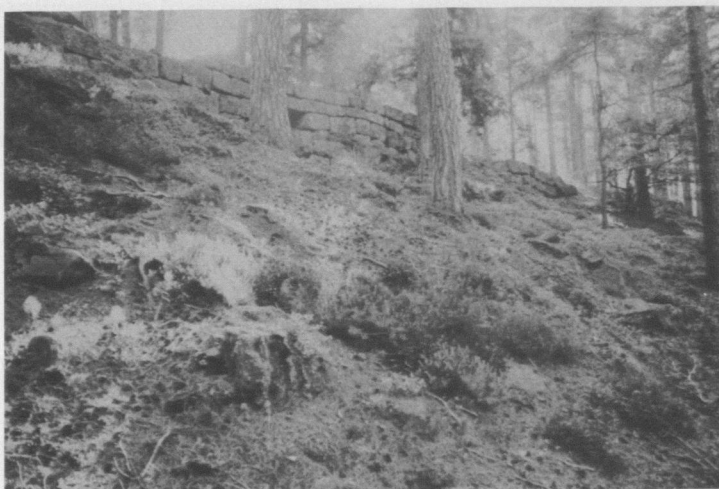
3 Westmauer vom Berghang (von Nordwesten).
