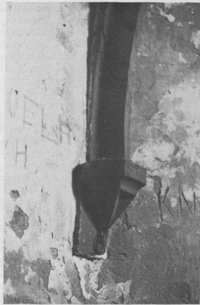
Abb. 13. Lichtenberg, Faltwerkkonsole im Nordturm des „Donjon“ (4 auf Abb. 3; Foto Th. Biller)
