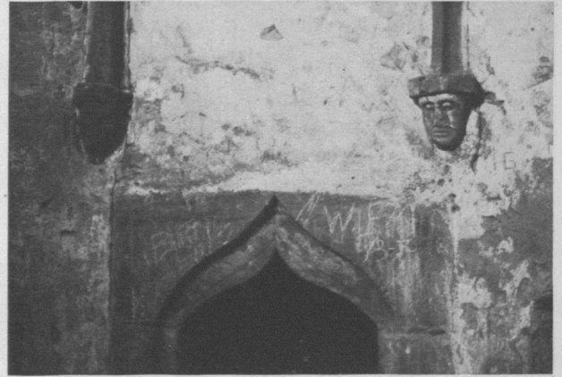
Abb. 16. Lichtenberg, Kielbogenabschluß einer Pforte und zwei Kopfkonsolen im Nordturm des „Donjon“ (1 u. 2 auf Abb. 3; Foto Th. Biller)
