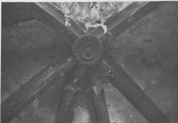
Abb. 15. Lichtenberg, Schlußstein im Nordturm des „Donjon“ (Raum B auf Abb. 3; Foto Th. Biller)
