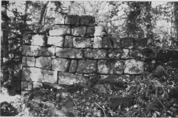
Abb. 10. Nordende des Trockenmauerrestes östlich der „Oedenburg“ von Westen (Foto Th. Biller)
