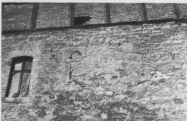
Abb. 8. Hausneindorf, Wohnbau mit vermauertem, dreiteiligem Spitzbogenfenster, Foto: Biller
