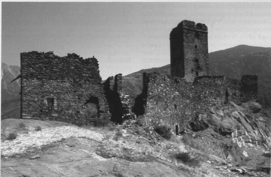
Fig. 5 : Ruine Montjovet, die Kernburg von Süden. In dem Ringmauerstück direkt links vom Bergfried, über der Rechteckpforte, zeichnet sich der flache Giebel eines älteren Gebäudes ab. Ganz links der spätere, mehrphasig romanische Wohnbau.
